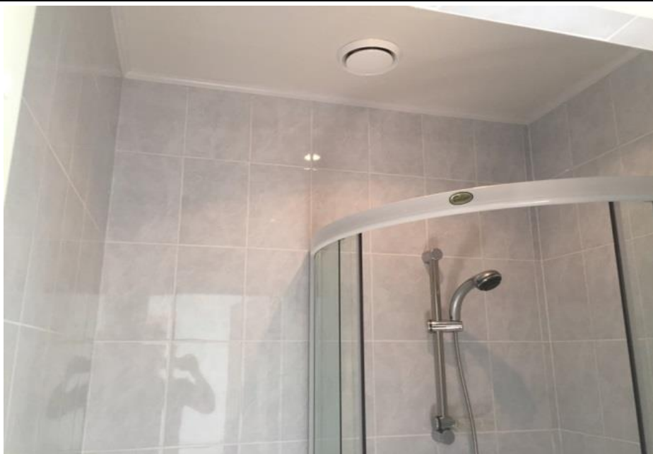
Вид помещений административного здания (2 этаж)
