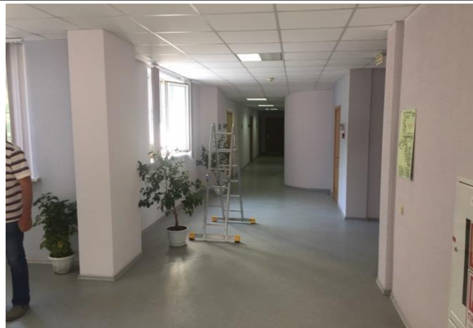
Вид помещений административного здания (2 этаж)
