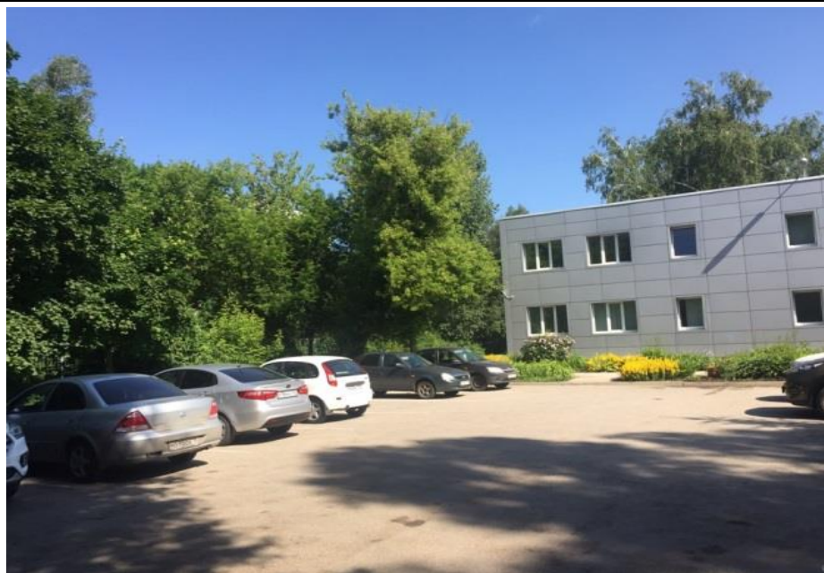
Общий вид административного здания, парковка
