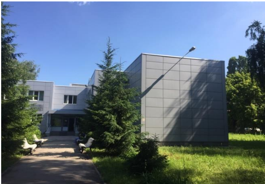
Общий вид административного здания
