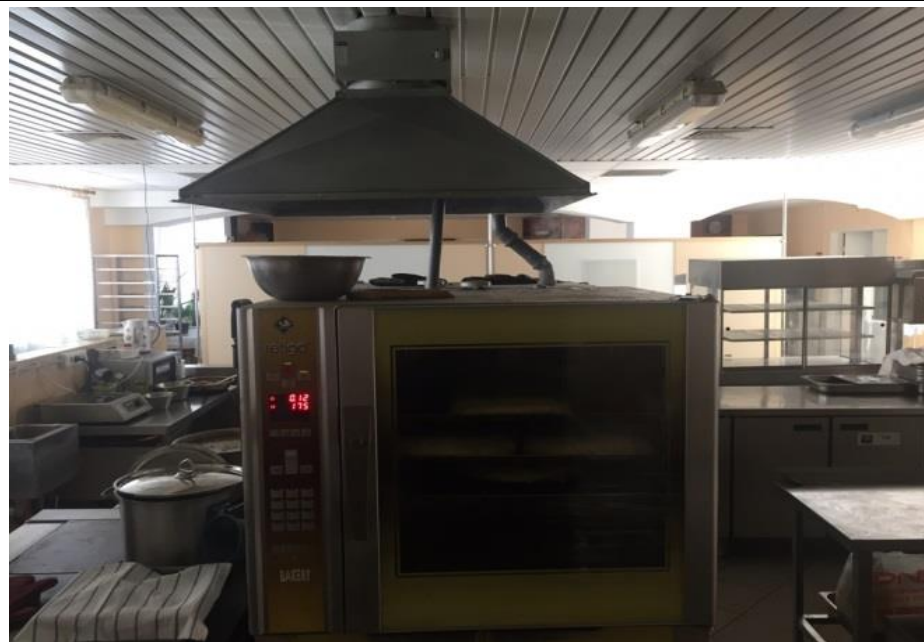
Вид помещений административного здания (1 этаж)
