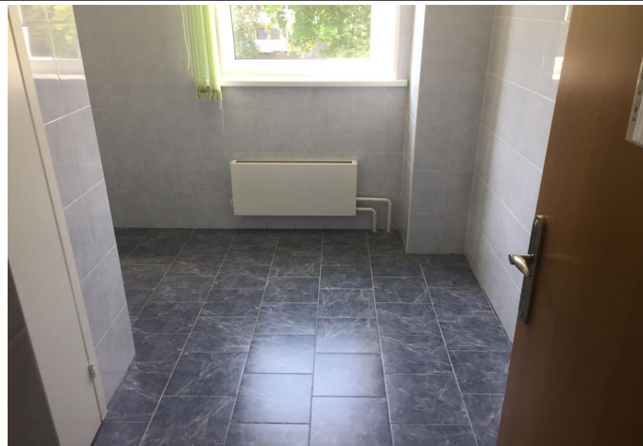
Вид помещений административного здания (2 этаж)
