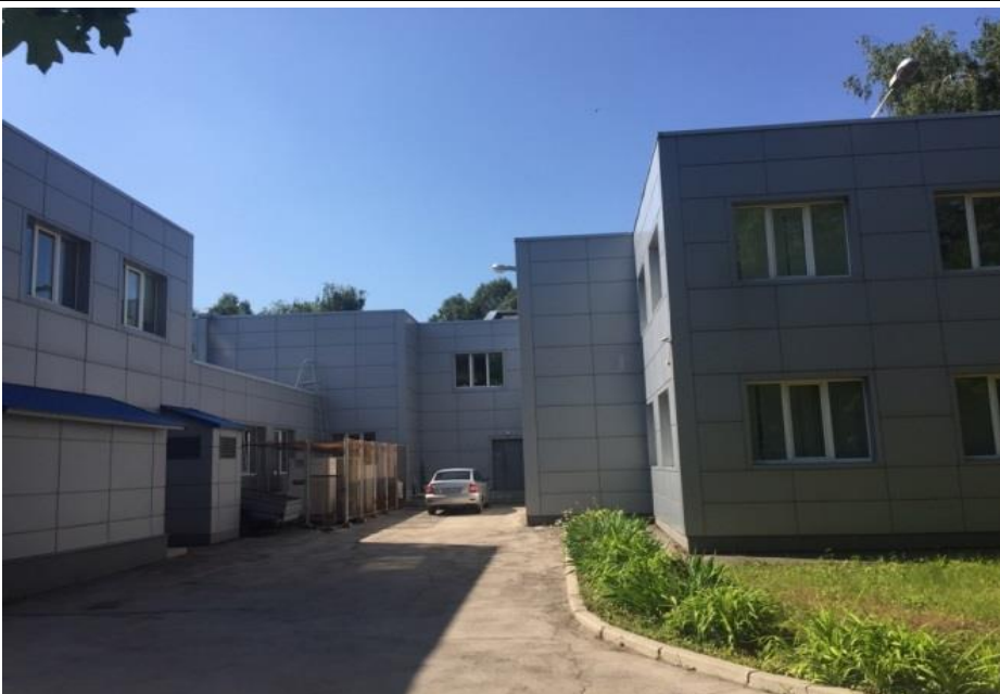
Общий вид административного здания
