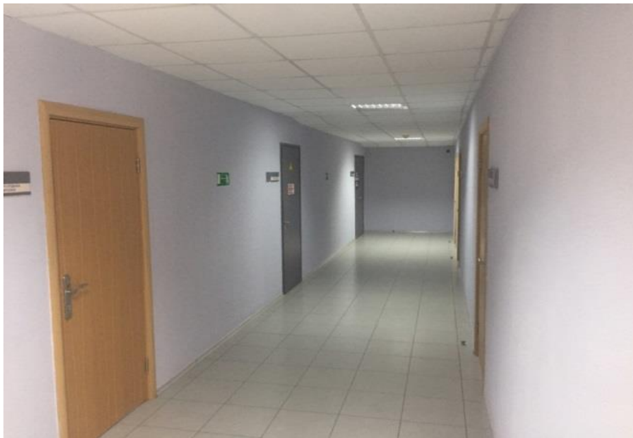
Вид помещений административного здания (1 этаж)
