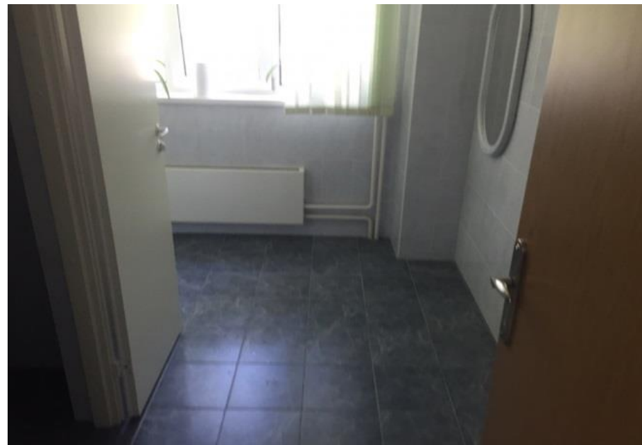
Вид помещений административного здания (1 этаж)
