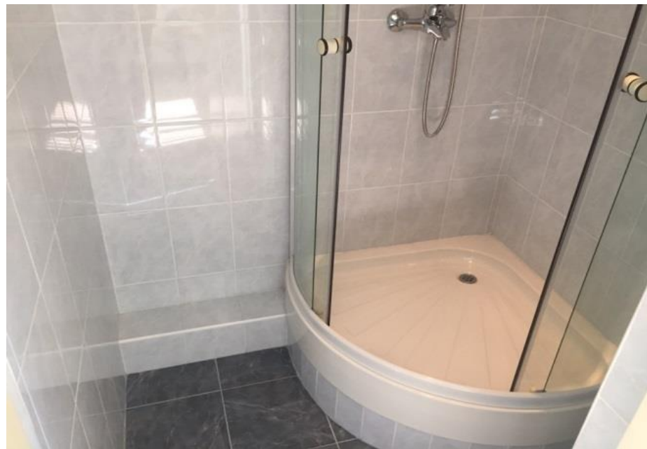
Вид помещений административного здания (2 этаж)
