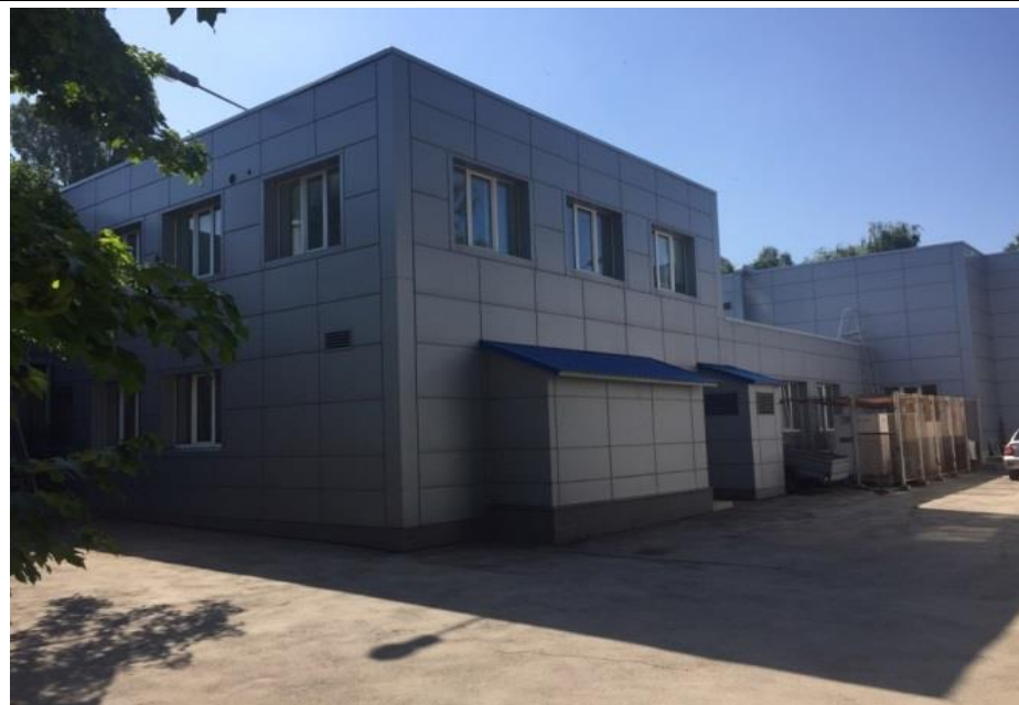
Общий вид административного здания
