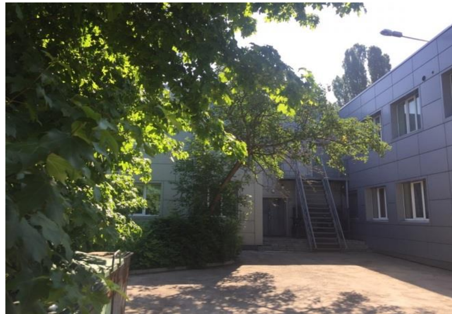
Общий вид административного здания
