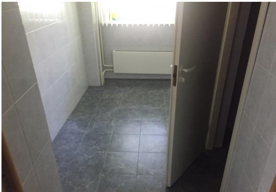
Вид помещений административного здания (1 этаж)
