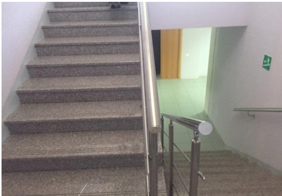
Лестница на второй этаж здания
