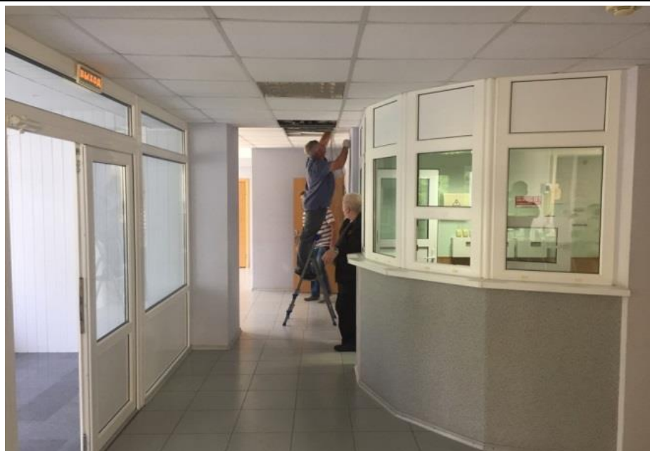
Вид помещений административного здания (1 этаж)
