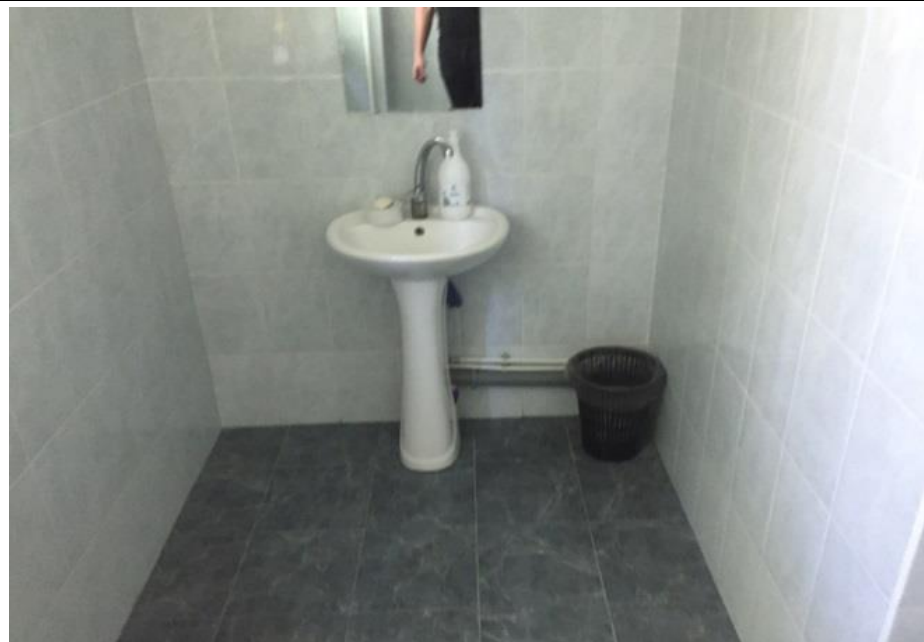
Вид помещений административного здания (1 этаж)
