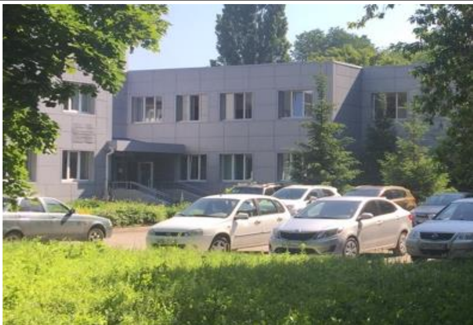
Общий вид административного здания, парковка
