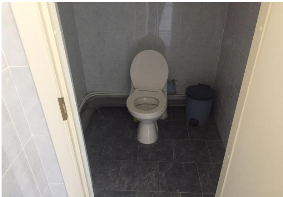
Вид помещений административного здания (2 этаж)
