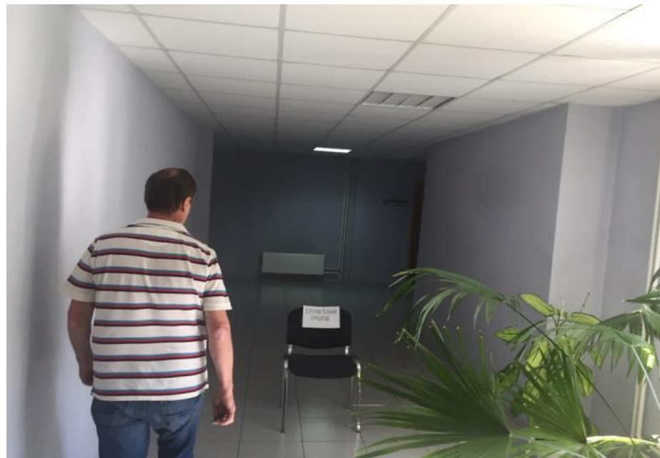
Вид помещений административного здания (1 этаж)
